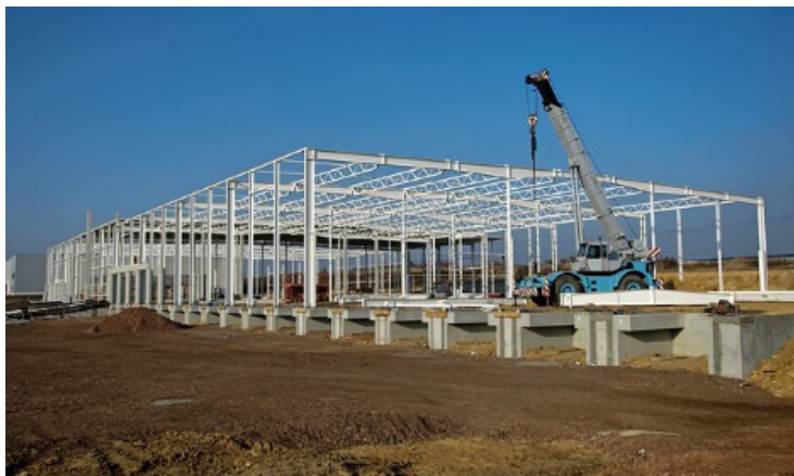
Figura 7.1 – Estrutura metálica para galpão. Fonte: Nicole (2017).
