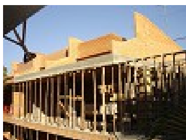
Figura 4 – Início da obra de construção do bloco de novos laboratórios – conclusão em janeiro de 2007
