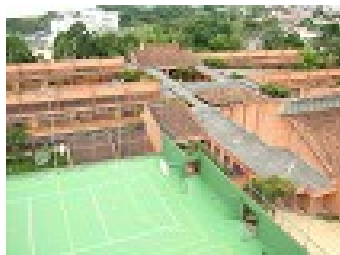
Figura 8 – Reforma da quadra de esportes.
