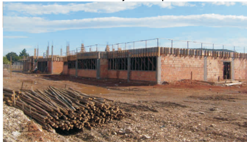
Foto 2 - Início das obras de construção do Câmpus.
