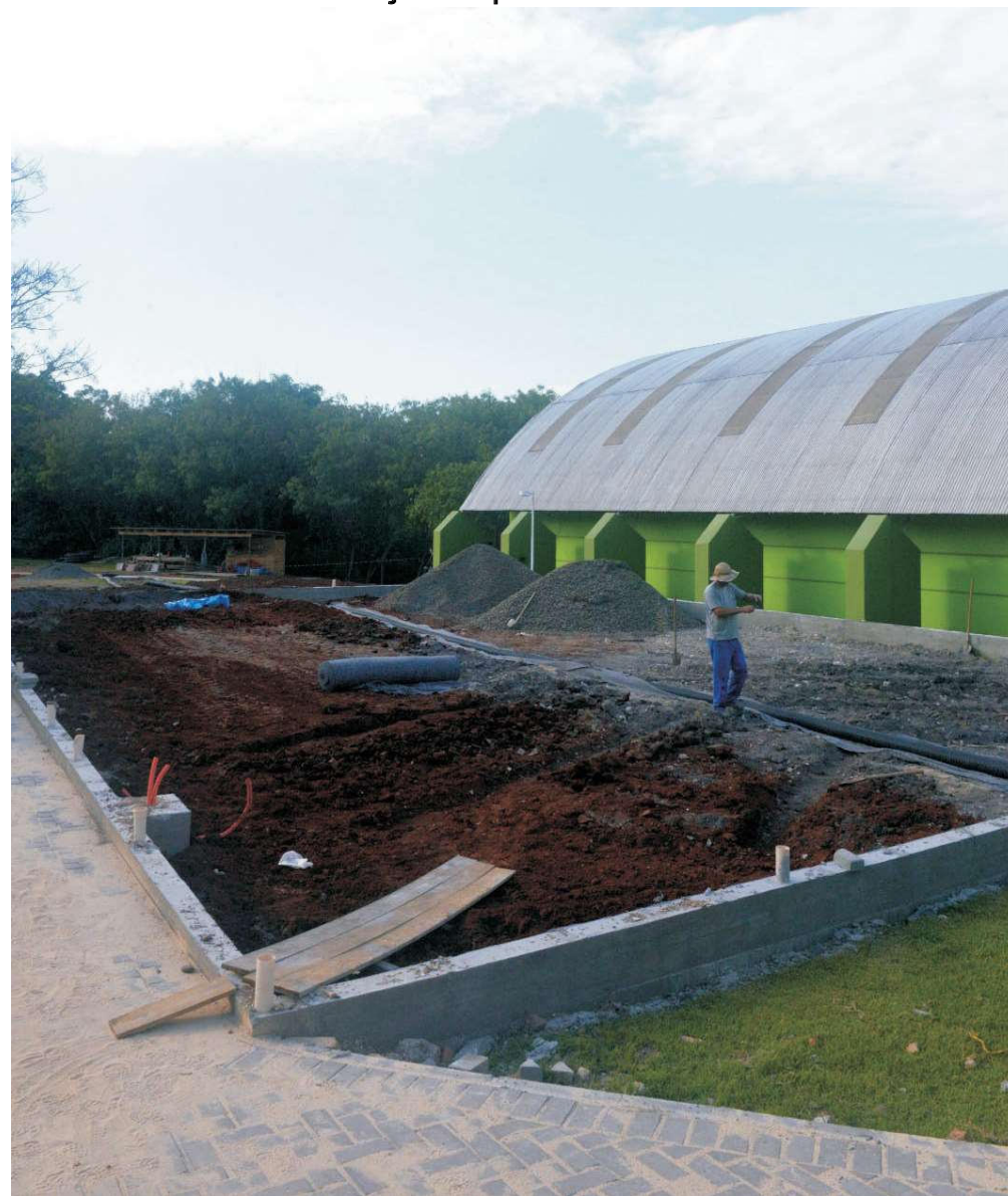
FOTO 12 - Obra de construção da quadra de areia.
