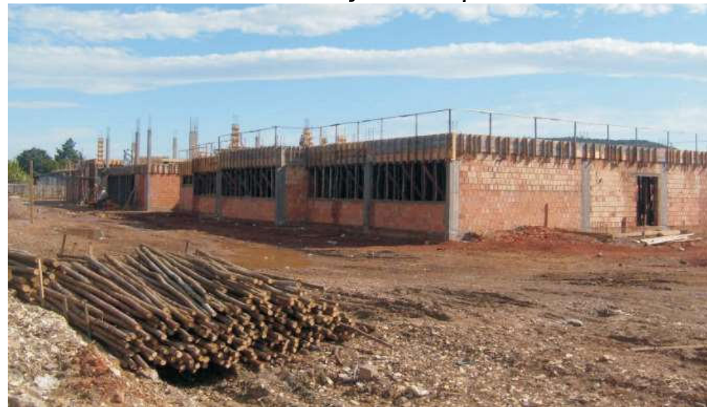
Foto 2 - Início das obras de construção do Câmpus.
