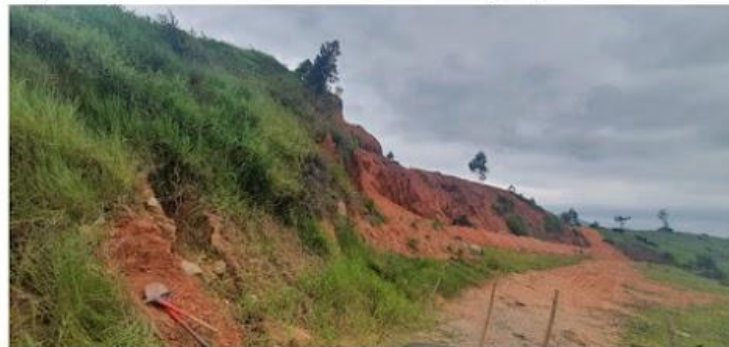
Figura 1 - Talude de coleta do solo em Biguaçu - SC.
