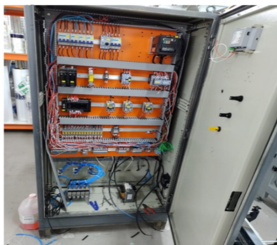
Figura 1 – Montagem do painel da bancada de testes
