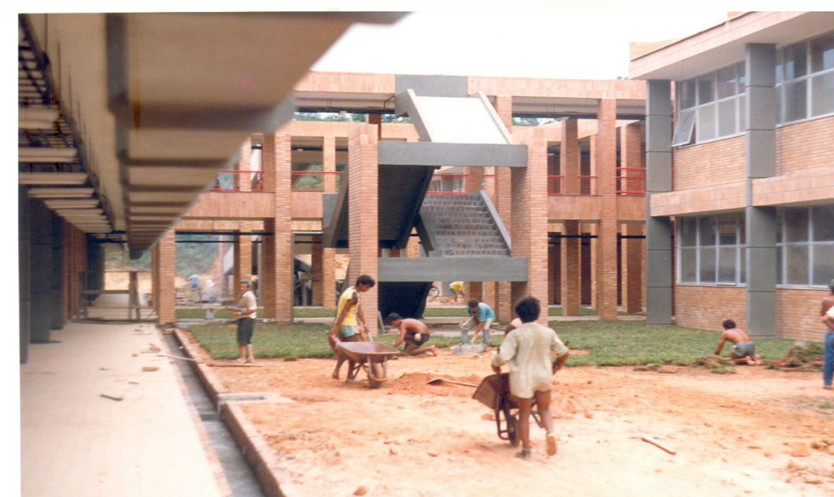
Figura 2 - Construção ETFSC/UNED SJ
