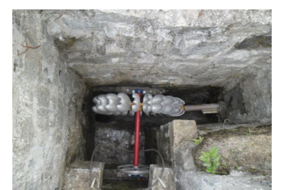
Fig. 9 - Montagem no Local
