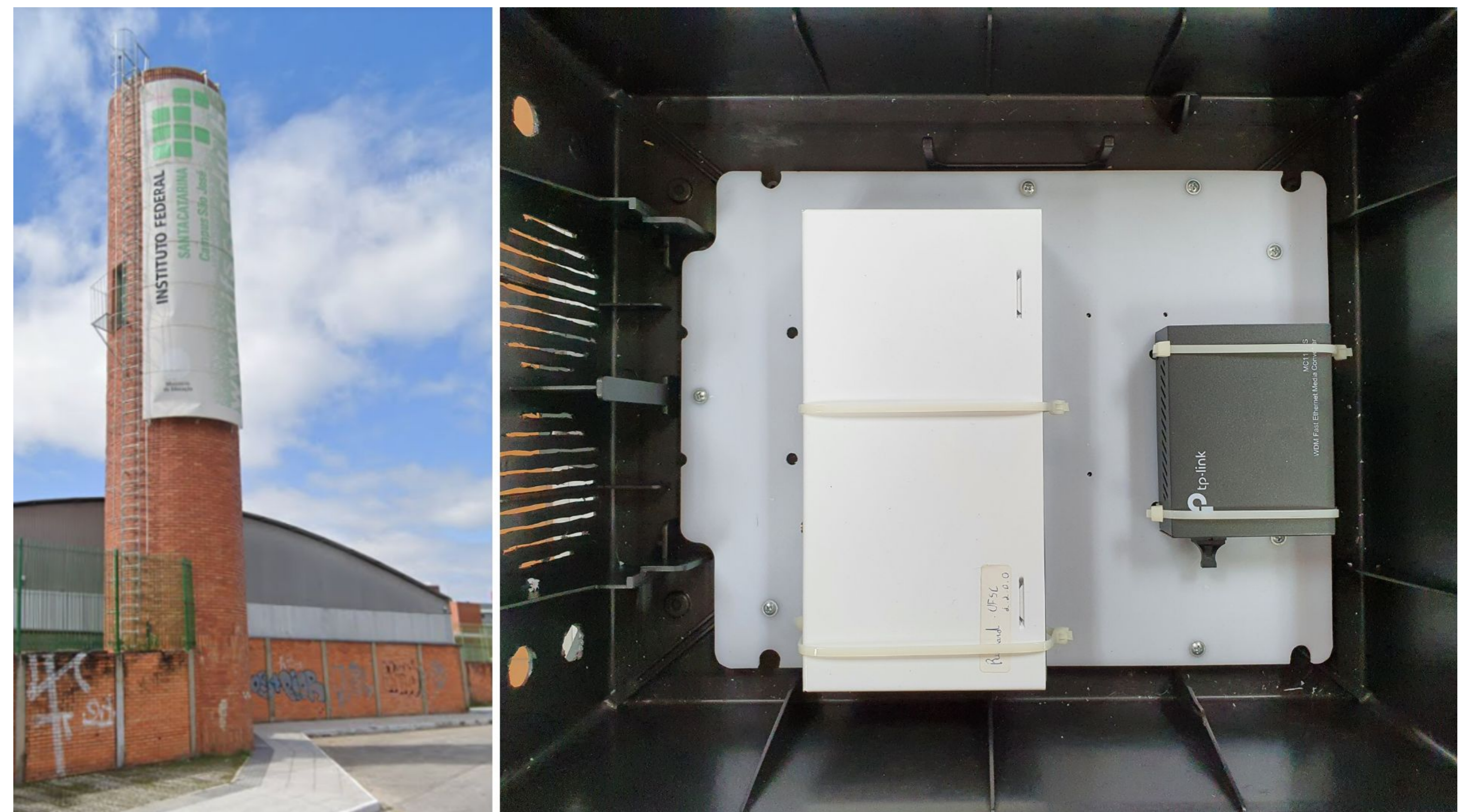
Figura 2: Local em que pretende-se instalar o gateway, o respectivo elemento e a caixa que irá comportá-lo
