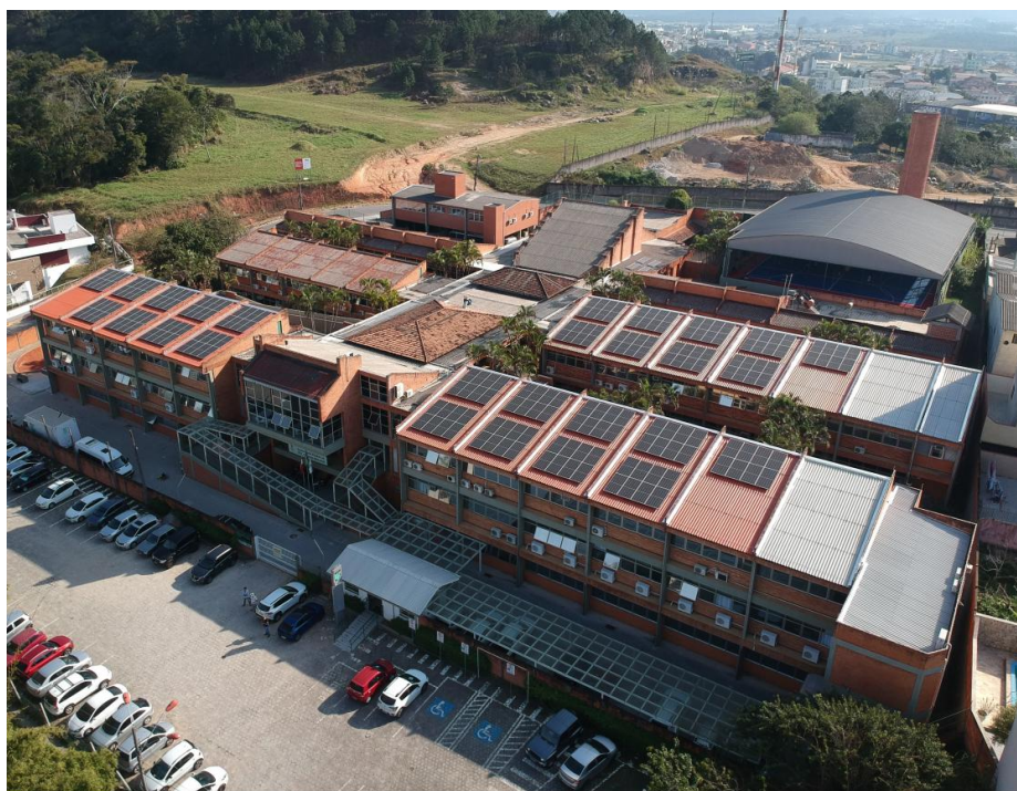
Figura 12 - Usina Solar Fotovoltaica do Câmpus São José.
