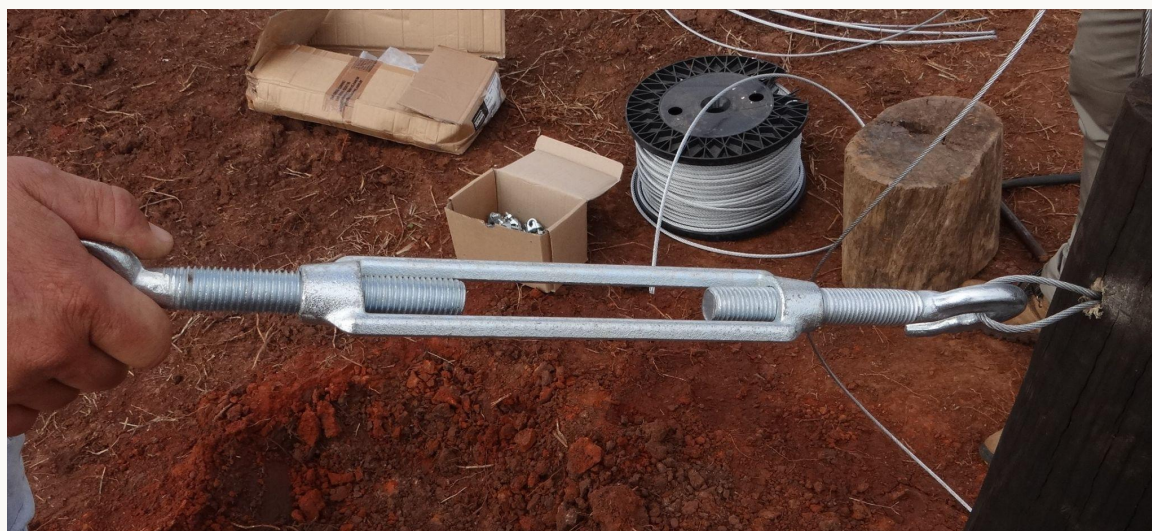
Figura 28. Exemplo de esticador de cabo de aço de 1" 25 mm com carga de trabalho de 600 kgF utilizado em uma área de 5.500 m 2 .
