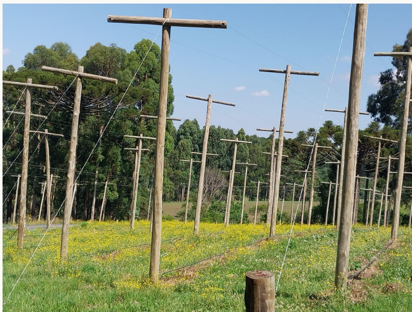
Figura 29. Estrutura instalada em forma de T.
