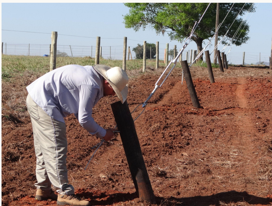
Figura 25. Instalação das estacas de sustentação e cabeamento lateral.
