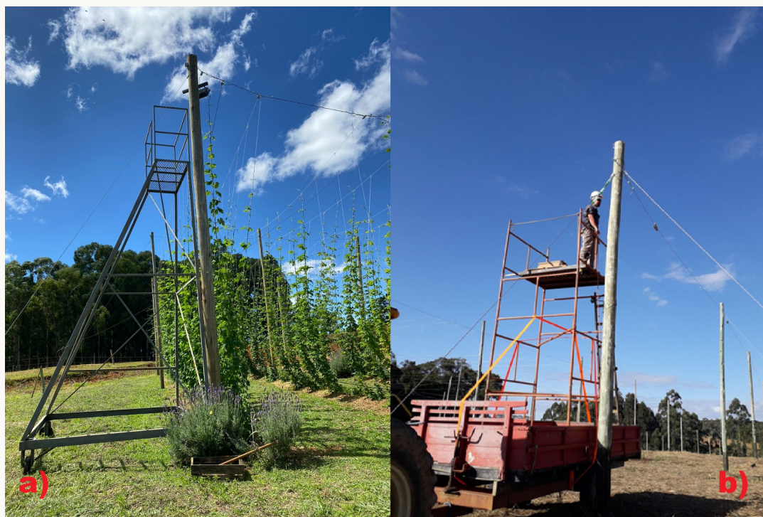
Figura 26. Instalação da estrutura com cabos de aço e arames utilizando diferentes recursos.
