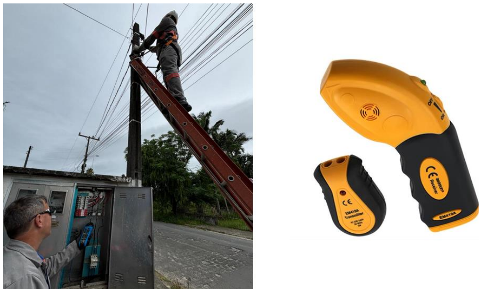
Figura 8 – Inspeção com medição de corrente (à esquerda) e detector de circuito (à direita)
