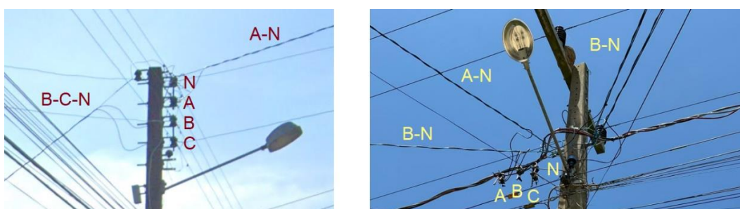
Figura 7 – Exemplo de inspeção visual para identificação da relação de conexão TD-UC
